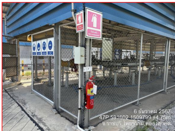
การติดตั้งถังดับเพลิงสถานีควบคุมก๊าซ
